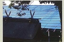
ブルー#3000による屋根材補修工事
