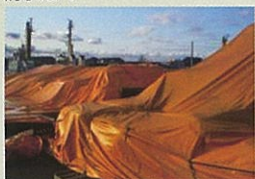
オレンジシートによる資材カバー
