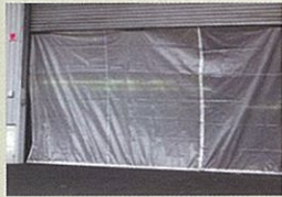
J透明シートの簡易間仕切り
