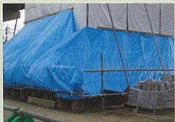
ブルー#3000橋梁据置箇所の防水カバー
