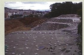
#7000による高速道路基礎カバー
