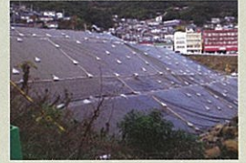
ODシート法面補強
