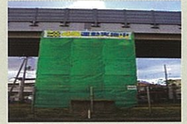
メッシュシートによる橋梁柱の塗装補修
