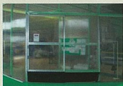
クリアクロスによる工場内作業室間仕切り
