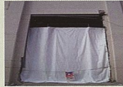
防災シートの出入口カーテン
