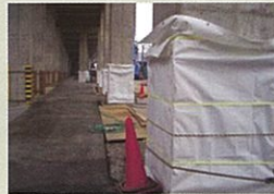
防災シート線路柱一時補強
