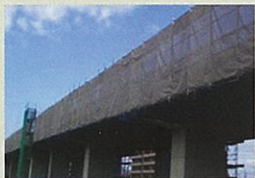
メッシュシートによる橋梁工事
