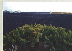
ブラックシート法面補強
