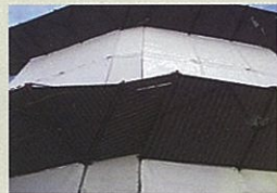
防災シートのビル上層部分工事
