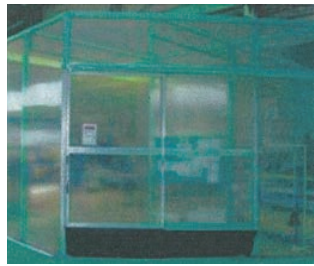
UVクリアシートの作業室間仕切り
