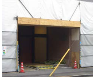
防災シートの壁面養生シート
